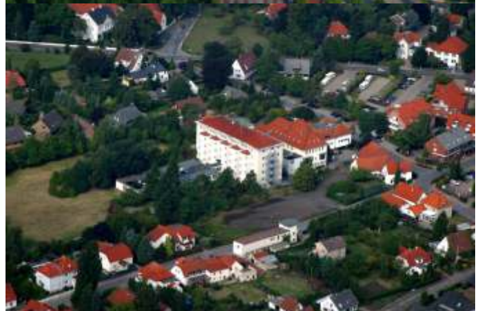
Klinikum Minden, Krankenhäuser Lübbecke und Rahden (von oben)
